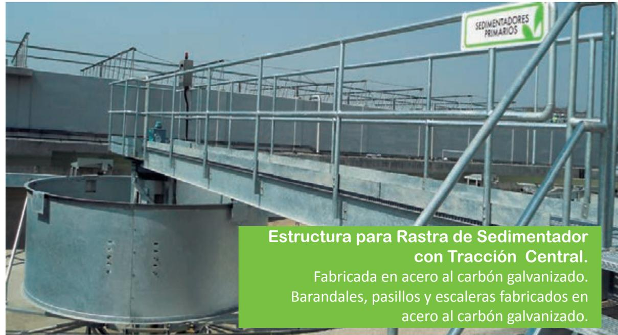
**Estructura para Rastra de Sedimentador
